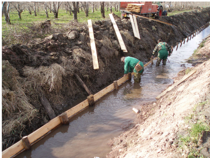
Abbildung 9: Böschungsbefestigungsarbeiten bei einem Entwässerungsgraben.
