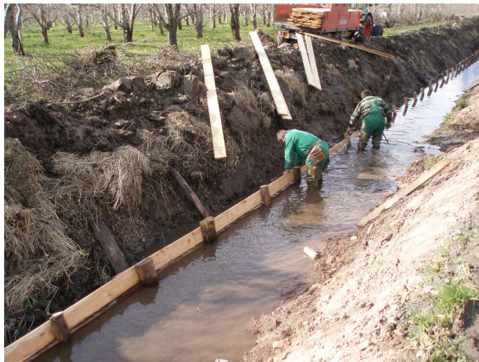
Figura 9: Lavori di consolidamento della scogliera di una fossa.
